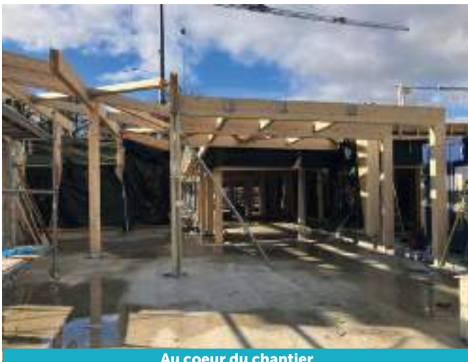
Au coeur du chantier
